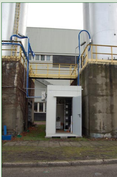
Stacja pomiaru emisji na terenie FIAT AUTO POLAND
